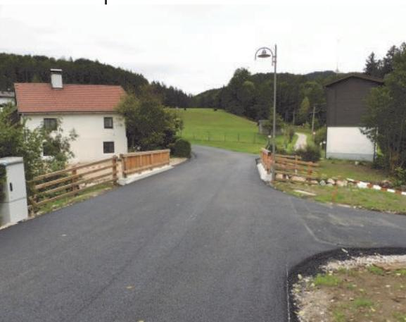
Nach Kontrolle der Brücke über den Ellmaubach im Bereich Steinbach (Mühlreith - Oberhaus) musste festgestellt werden, dass tragende Eisen im Beton sichtbar und angerostet waren. Außerdem kam es immer wieder zu Senkungen im Bereich außerhalb der Brückenwände. Dies hat die zuständige Abteilung beim Land, nach Zustimmung der Gemeinde Fuschl am See, dazu bewogen, die Brücke abzureißen und neu zu bauen. Während der Bauphase wurde eine eigene Fußgängerbrücke errichtet.
